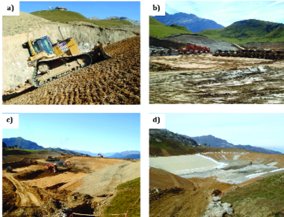
Şekil 6 2007'de Courchevel, Fransa Alplerinde kayak pistleri için yapay kar üretimi amacıyla su depolanmasında kullanılacak yeni Ariondaz su deposunun inşaatı (125 00 m 3 büyüklükte 2500 m yükseklikte).
